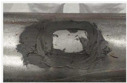
Le pipe est désormais près à être renforcé avec le REINFORCEKiT® 4D (R4D), en suivant les normes.
