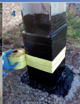
4 Enroulement Kevlar® et résine époxy
