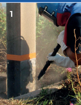
1 Préparation de surface Sa2½ / St3 et rugosité Rz > 60 µm
