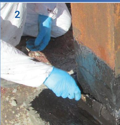
Application de la résine époxy pour protéger de la corrosion
