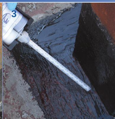
Application du mastic élastomère pour l'étanchéité
