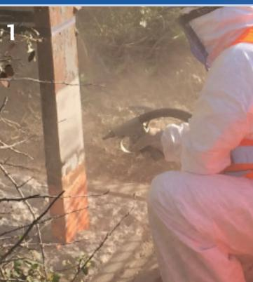
Préparation de surface Sa2½ / St3 et rugosité Rz > 60 µm
